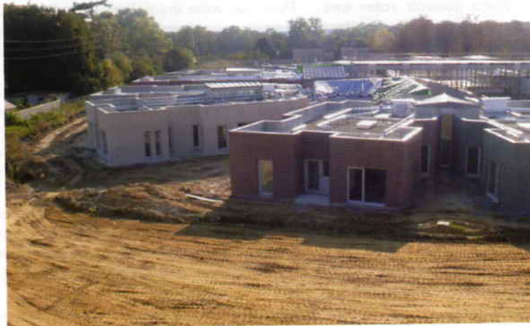
Construction du foyer d'accueil.
