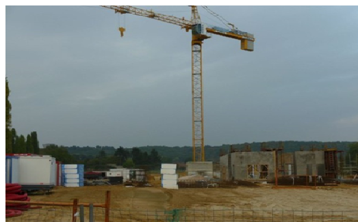
Etat des travaux en octobre 2010
